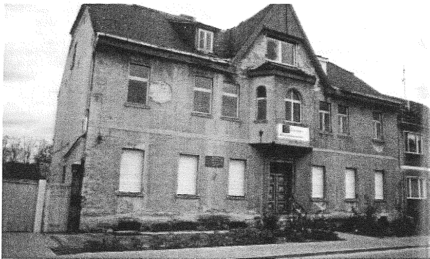
Cantiere di inserimento: la "Fattoria dei giovani d'Europa" di Deetz
